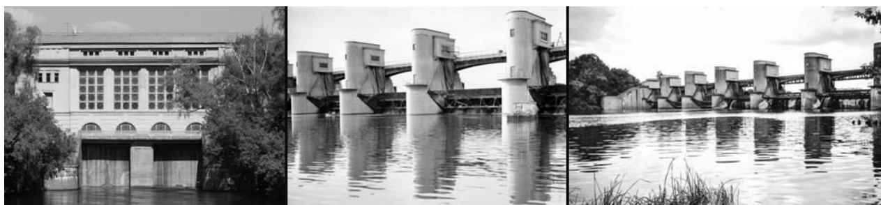
Рисунок 4. Объекты Перервинского гидроузла. Фото 2014 года [20]
