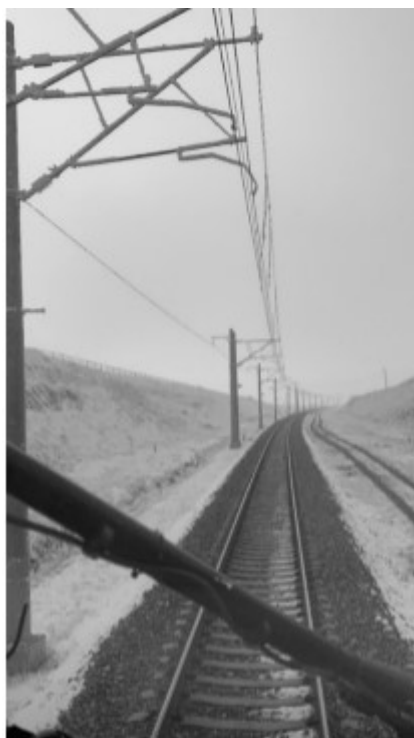
Рисунок 1. Гололёда образования на контактной подвеске в Джизакской области
